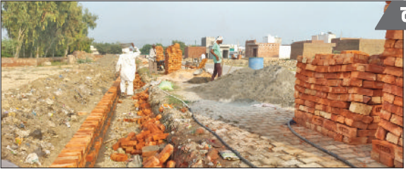
कलायत। डॉ. भीमराव आंबेडकर मार्ग पर स्मार्ट रोड योजना के तहत चल रहा निर्माण कार्य और मौके पर पड़ी निर्माण सामग्री । फोटो :हरिभूमि
